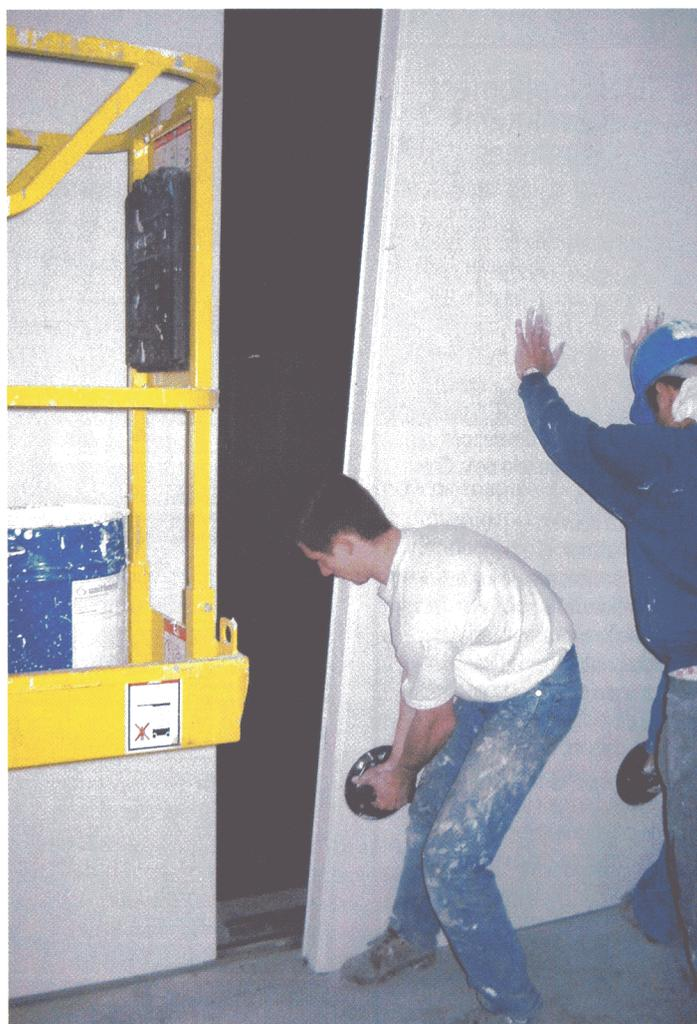
LES PAREMENTS LISSES sont en acier galvanisé laqué (revêtement PVDF 35 et 55 µm, PET 55 et 150 µm agréé hygiène) ou inox (brossé, PET 150 m). (Doc. Pittsburgh Corning France.)
